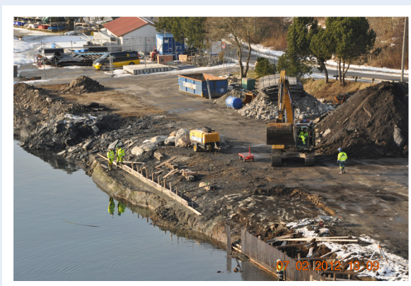
Rehabilitering av A-bryggen og servicekaien i 2012 var et stort prosjekt.
